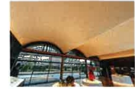
内装改修 畳出空間等の撤去 天井、壁は本漆喰による改修
